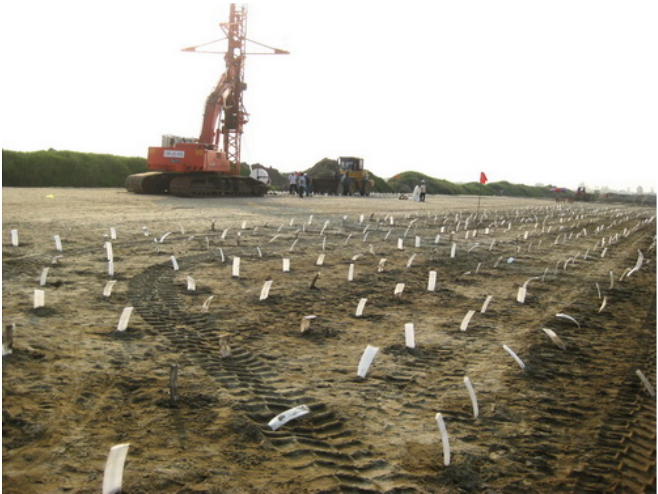
Hình trình bày thi công gói thầu EX7 - dự án đường ô tô cao tốc HN-HP
