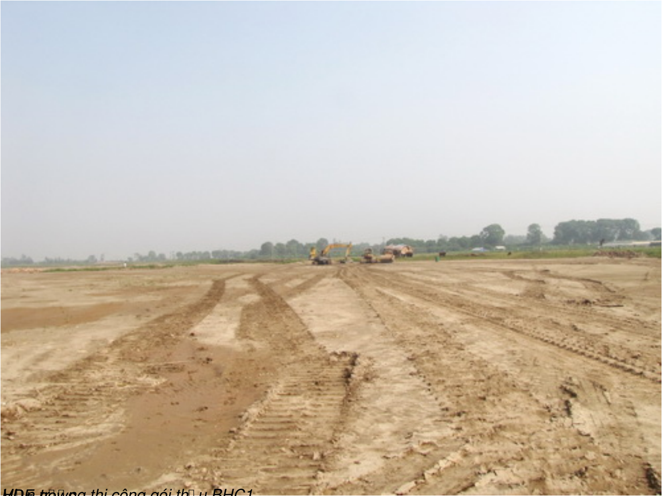
MDF-trên sg thi công gói thầu BHC1
