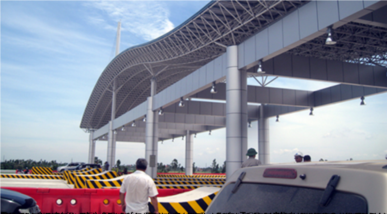
Figure 7.4: Hệ thống thu phí (Sông Đà) hiện tại, trước khi xây dựng dự án mới, H i D
