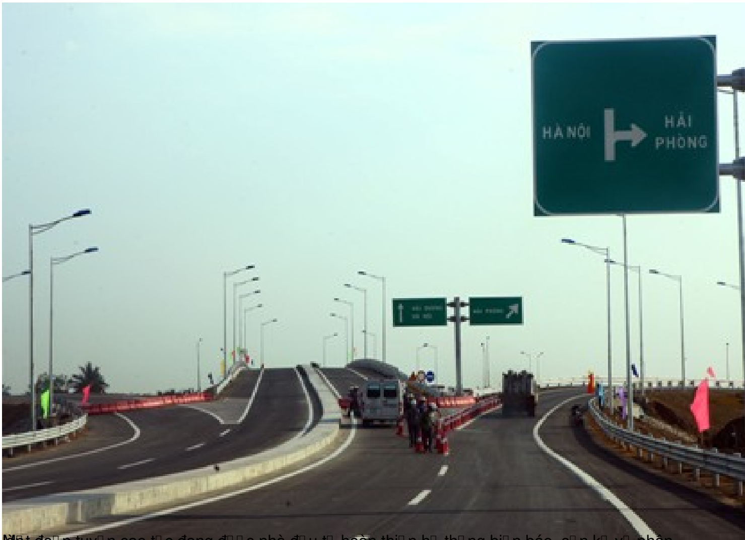
Một đoạn tuyến cao tốc đang được nhà đầu tư hoàn thiện hệ thống biển báo, sơn kẻ vạch phân
