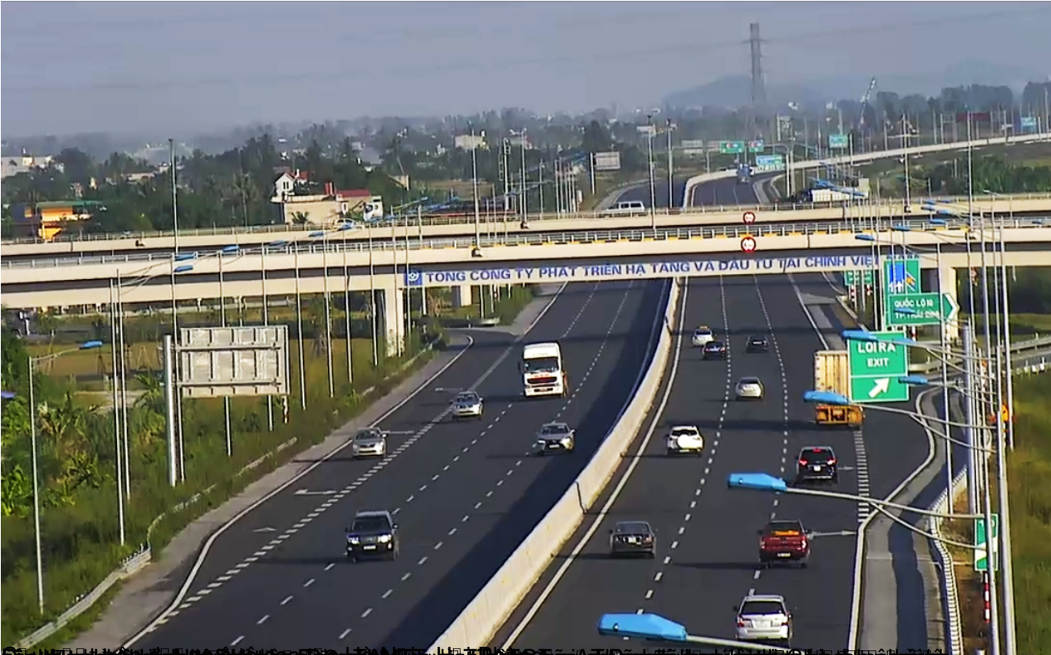
Đẩy nhanh tiến độ thi công, đảm bảo chất lượng và tiến độ thi công của Dự án Phát triển hạ tầng giao thông tại địa phương.
