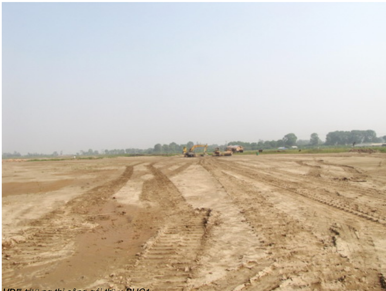
MDF-trênsg thi công gói thầu BHC1
