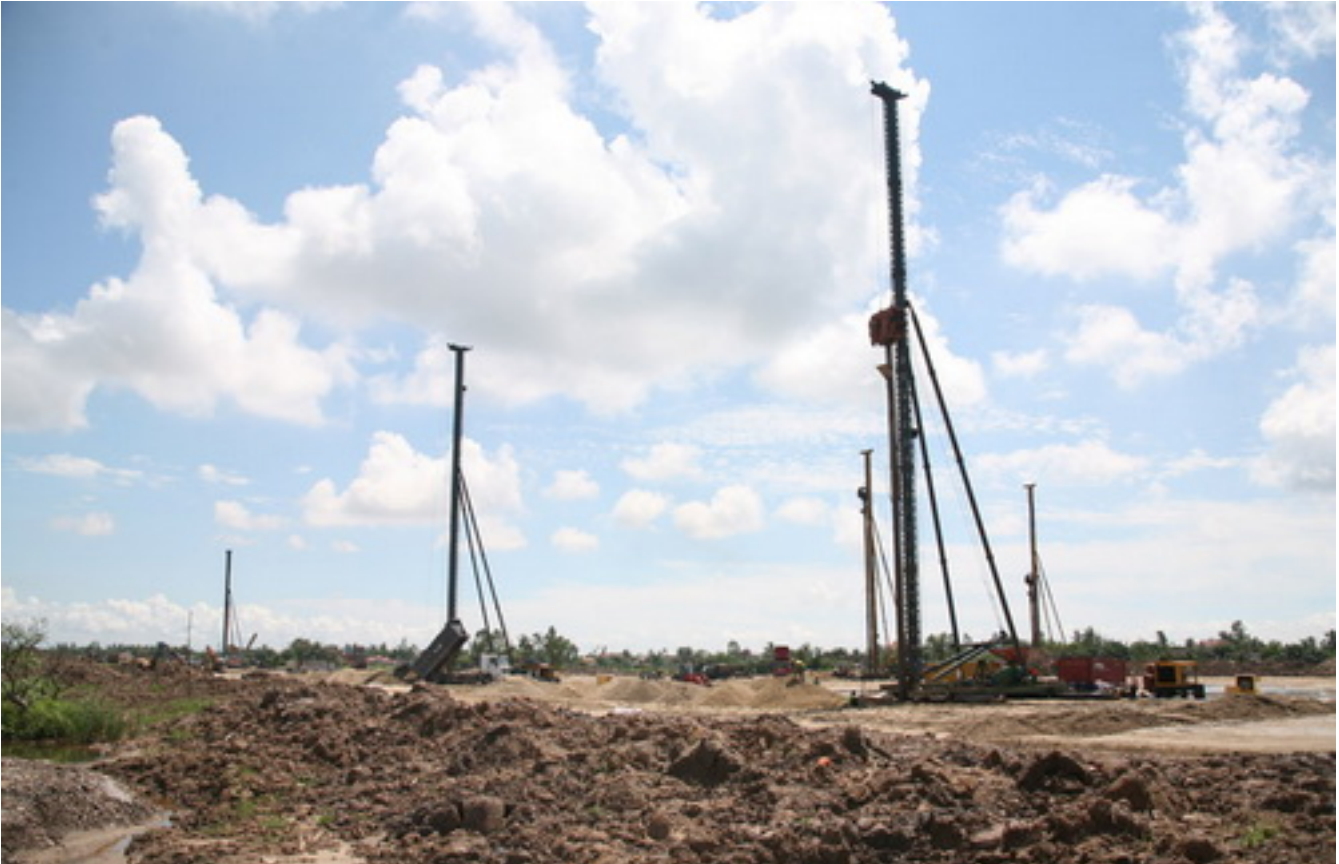
Thi công các gói thầu EX9 và EX10
