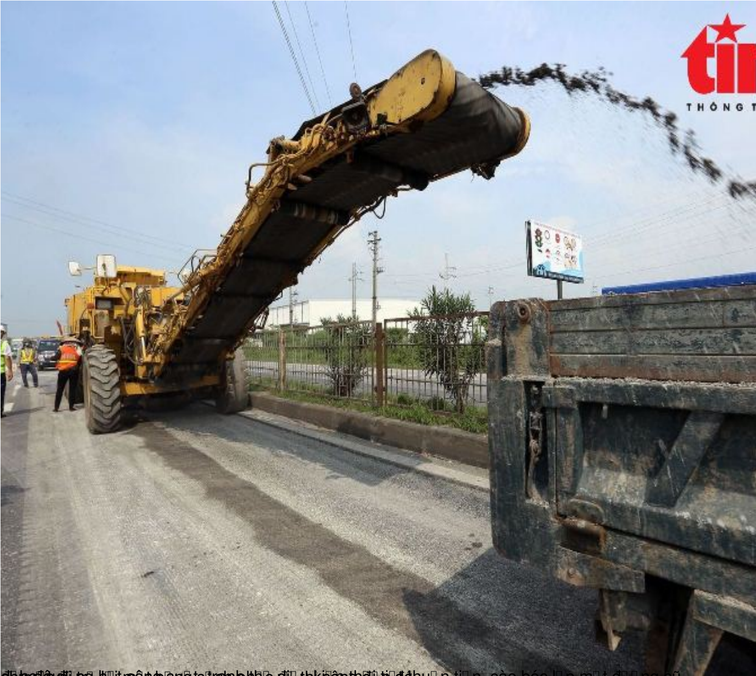
Đầu tiên, công nhân sẽ rải một lớp cát mỏng để làm phẳng mặt đường, tiếp theo là rải một lớp đá nhỏ để làm cứng mặt đường, cuối cùng là rải một lớp đá to để làm cứng mặt đường.
