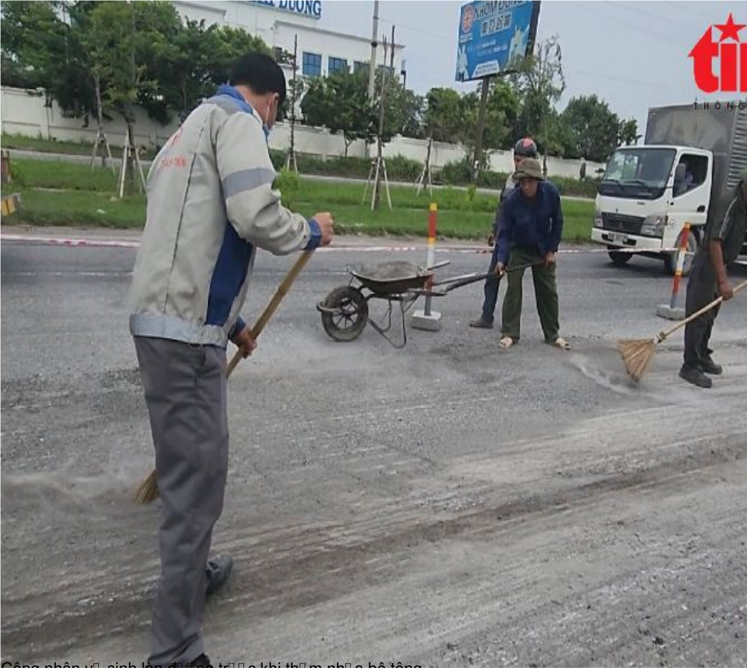
Công nhân vệ sinh làn đường trước khi thi công nhả bê tông.
