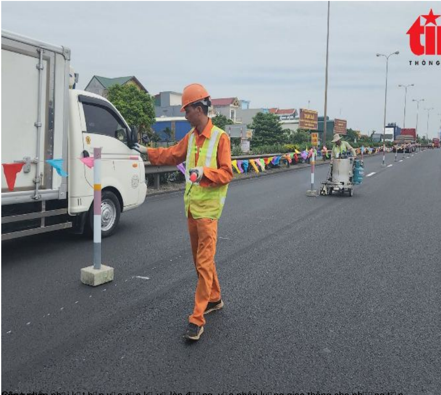
Công nhân phải kết hợp vữa sên kê và lăn đường, vữa phân luồng giao thông cho phương tiện
